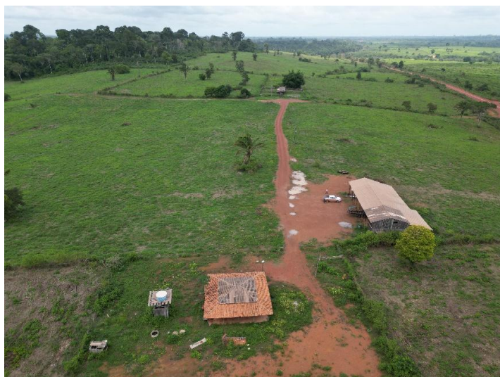
ESTRUTURA, CASA PARA FUNCIONÁRIO, GALPÃO E CURRAL
